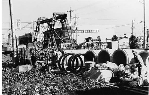
図 2.2 下水道管路新設工事（昭和 50 年代）
