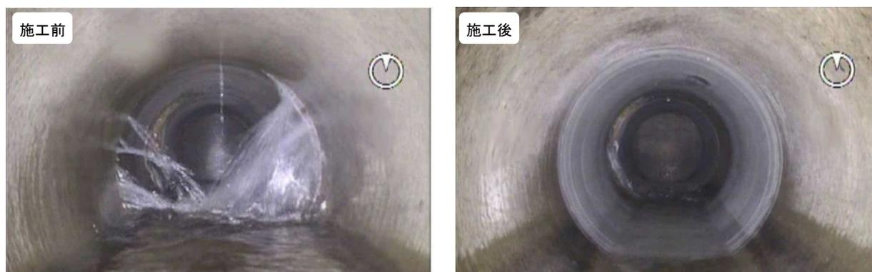
図 3.28 管路補修工の施工前後
