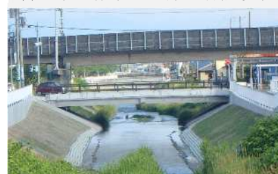
富士早川都市基盤河川改修事業
