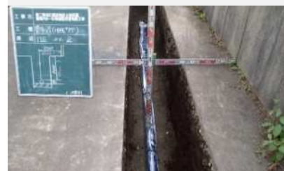
水道管布設工事の立ち会い
