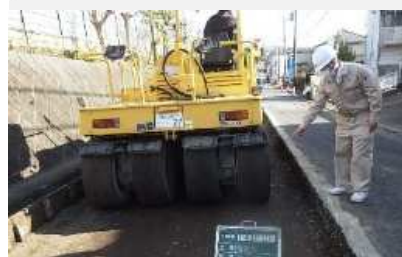
道路舗装工事の立ち合い
