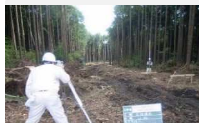
林業専用道飯森線施工状況
