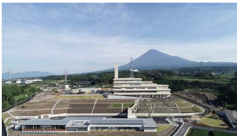
新環境クリーンセンター全景
