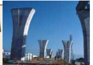
▲建設中の新東名橋脚
