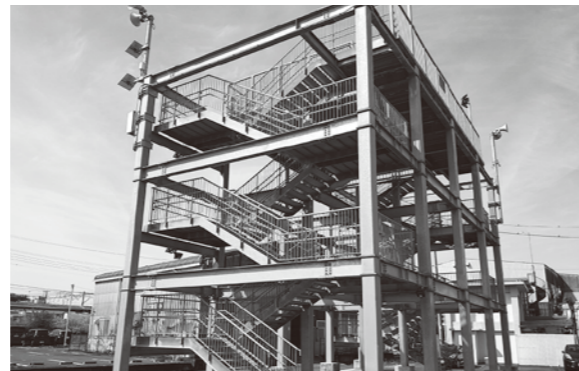
▲津波避難タワー
