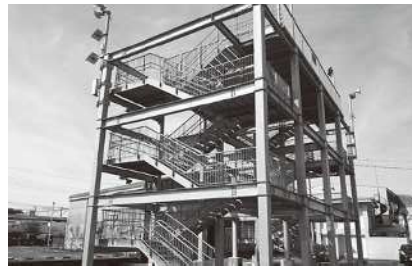
▲津波避難タワー
