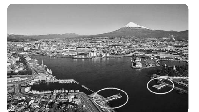
機能強化に向けた実施設計を行う第3波除堤（○部分）
