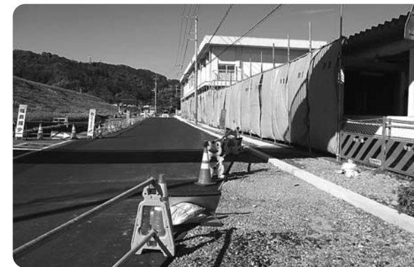
県道鷹岡柚木線拡幅工事と岩松中学校
