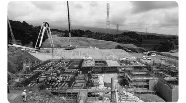
建設が進む新環境クリーンセンター
