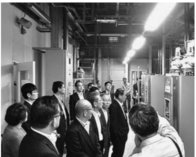
下水道バイオマスエネルギー利活用施設を視察
