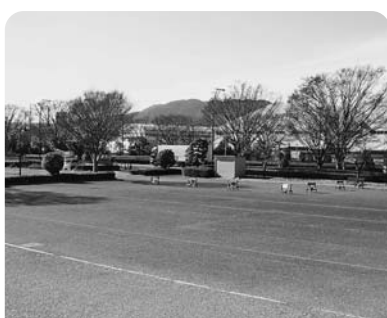
改修する多目的広場
