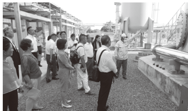
▲東部浄化センターの新型消化槽を視察する様子
