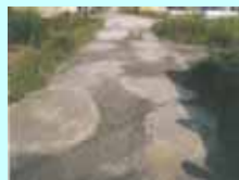
農道の窪みの補修
