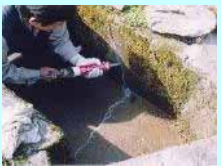
水路のひび割れ補修
