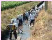
水路の泥上げ
