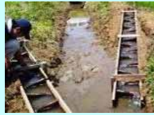
水田魚道の設置
