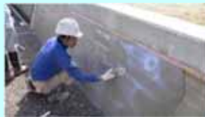
老朽化した水路壁のコーティング
