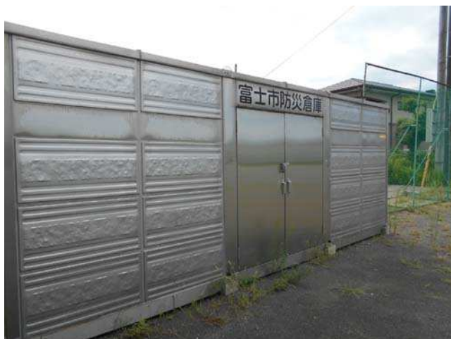
⑦防災倉庫
