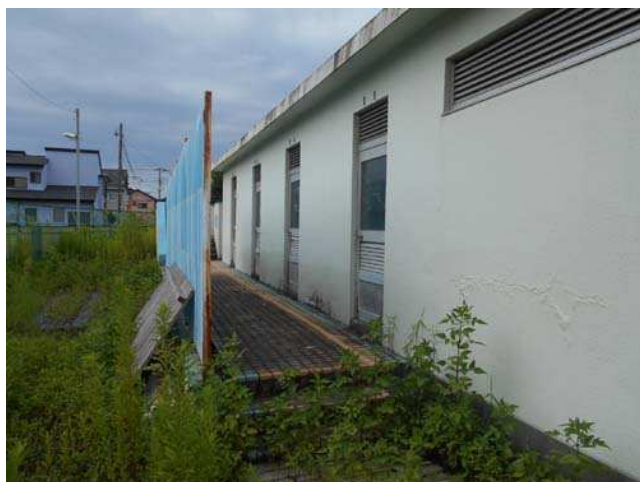
⑧プール入口
