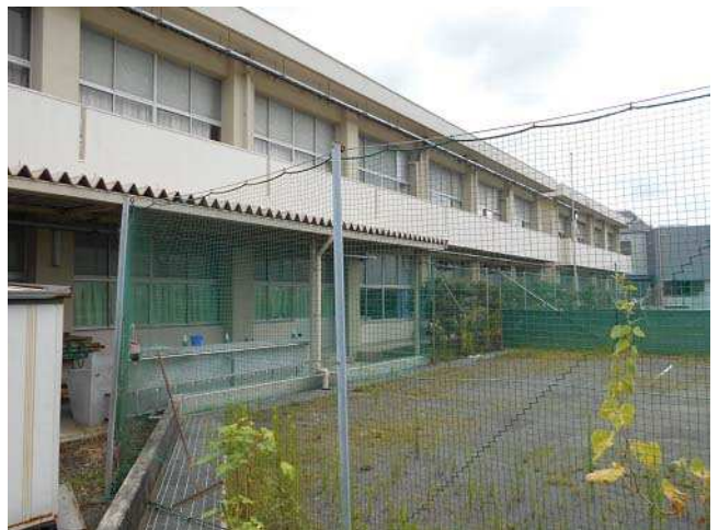
⑥校舎棟外観
