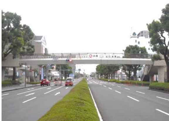
【鋼橋】富士市役所前歩道橋
