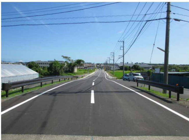
【完成写真】矢印①の方向から撮影
