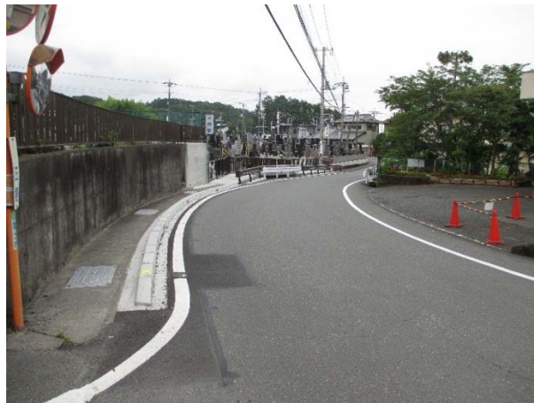
【完成写真】 矢印の方向から撮影
