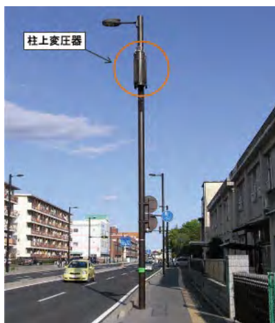
図：柱状型変圧器の例
