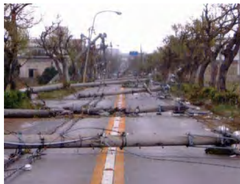
図：電柱倒壊の様子
