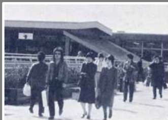
北口駅前歩道橋の完成
