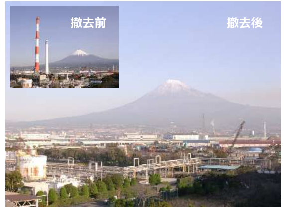
煙突撤去前後の景観
