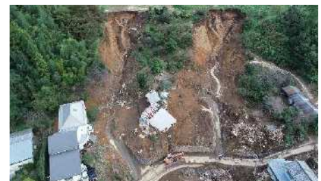
令和元年台風 19 号による土砂災害 (出典：国土交通省 HP)
