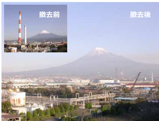
煙突撤去前後の景観
