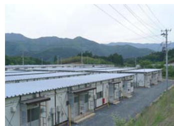
仮設住宅（建設型）の例（大船渡市）
