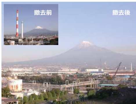
煙突撤去前後の景観
