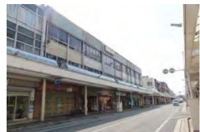
[吉原商店街の防災建築街区]
