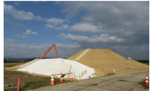
第 8 図 ハニカムフレームを設置
