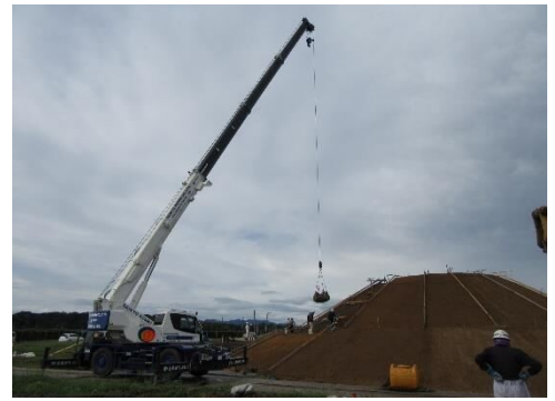
第 7 図 クレーンを使用した保護盛土作業
