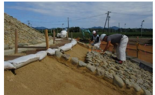
第 9 図 葺石復元作業
