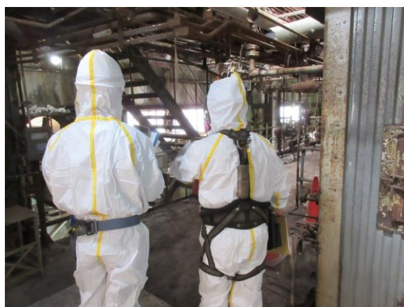
特定粉じん排出等作業立入検査
