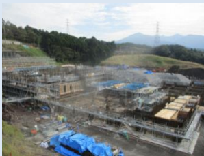
地下1階躯体工事中 (10月下旬)
