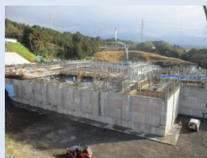
地下1階躯体工事終盤 (11月下旬)
