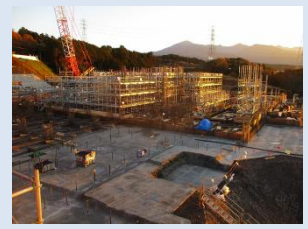
地上1階躯体工事中 (12月下旬)
