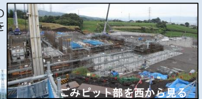
ごみピット部を西から見る
