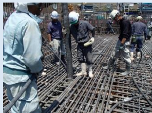
コンクリート打ち込み
