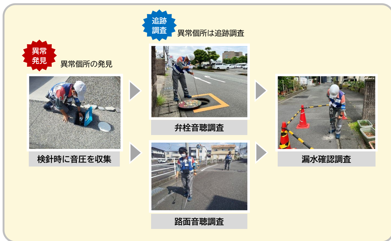
図4-13 検針時同時漏水調査イメージ
