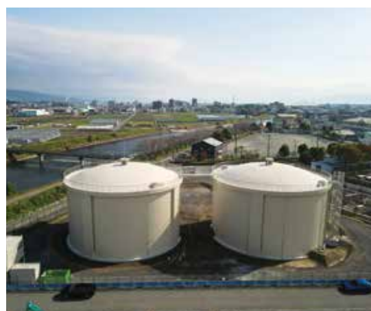
〈工事中〉令和6年11月撮影
