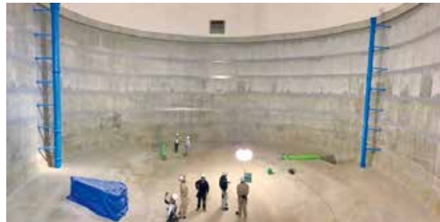
工事中の配水池内部の様子
