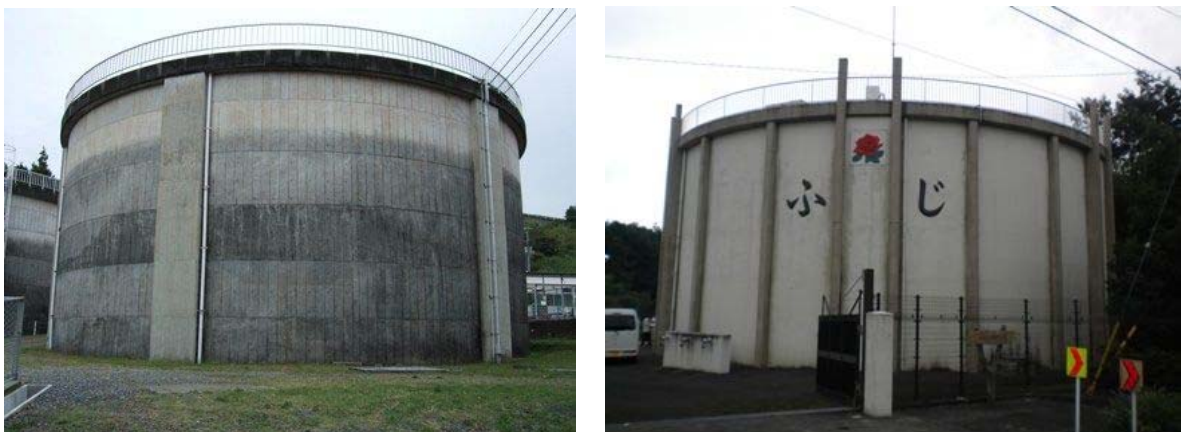
図 1.9 岩松配水池と今宮3号配水池
