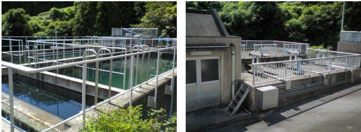
図 1.10 吉津浄水場の沈澱池と急速ろ過池
