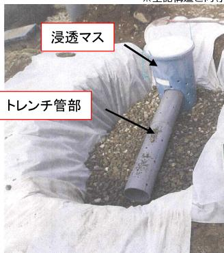
A型埋設施工例(手前の筒型部がトレーンチ管部です)
