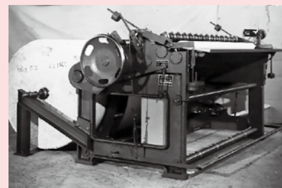
第58回企画展より 昭和40年頃のトイレットペーパー 巻取り加工機(株大成鐵工所蔵)
