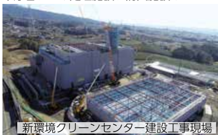
新環境クリーンセンター建設工事現場
