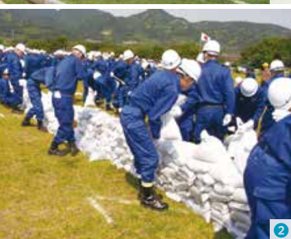
水防訓練の様子 ①水流を弱める「川倉工法」②土のう積み工法
