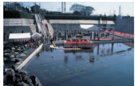
原田雨水貯留池（1995）
