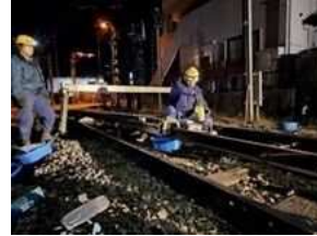
▲分岐器レール交換 本吉原 11 号 原田 51 号
