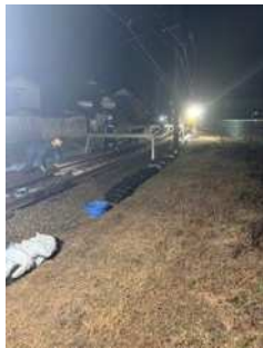
▲レール重軌条化 (本吉原～岳南原田間)
