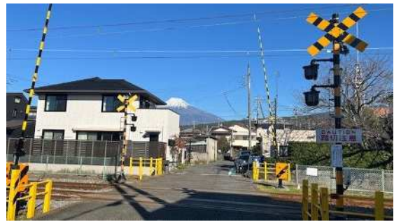
●踏切遮断機、警報機更新（大坪踏切）
