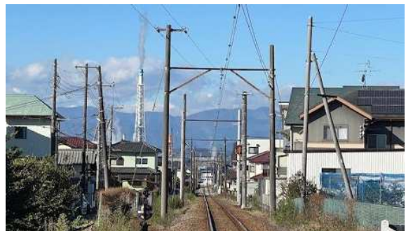
●電車線交換工事（須津駅構内）
