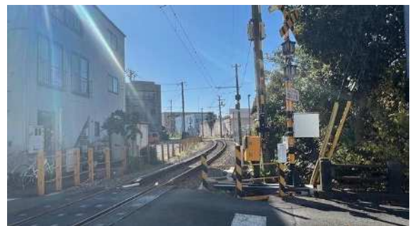
●踏切遮断機、警報機更新（本町南踏切）
