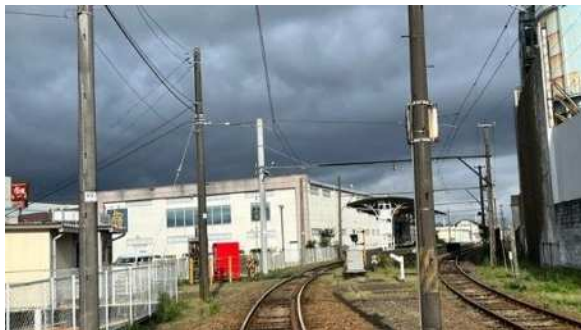
●電車線交換工事（吉原～本吉原駅構内間）
