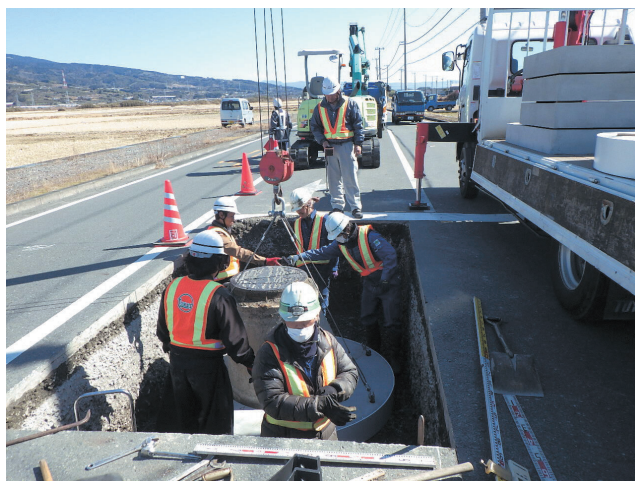
図 3.20 マンホール浮上防止工事
