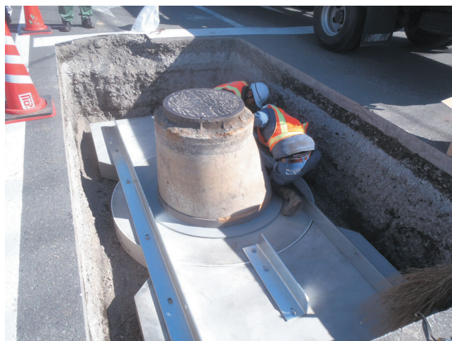
図 3.20 マンホール浮上防止工事
