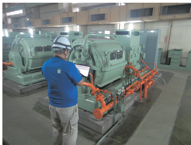
図 3.64 下水道施設(処理場)管理システムを 用いた設備確認
