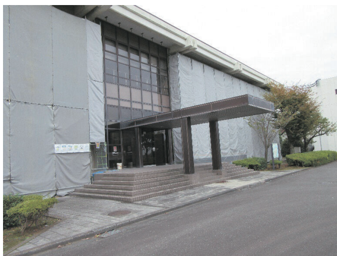
図 3.21 東部浄化センター沈砂池管理棟の耐震化
