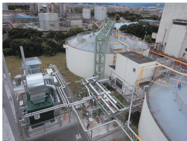
図 3.14 西部浄化センター消化ガス発電施設
