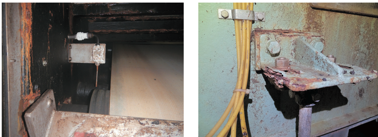
図 3.35 建築附帯設備と機械設備の腐食状況(西部浄化センター)
