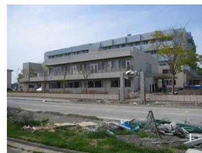
津波により被災した病院施設
