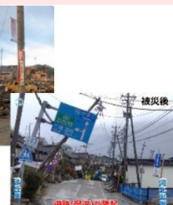
液状化による地盤の流動状況（内灘町）
