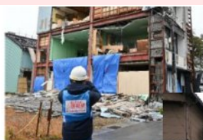
建築物の損壊状況（七尾市）
