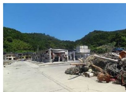
津波により被災した漁港施設
