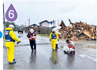
3月19日～25日 珠洲市 上水道の被害調査・復旧作業
