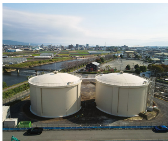
〈工事中〉令和6年11月撮影
