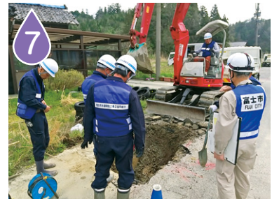
4月18日～24日 珠洲市 水道工事業者と共に復旧作業・ 現地で使うトラックの輸送
