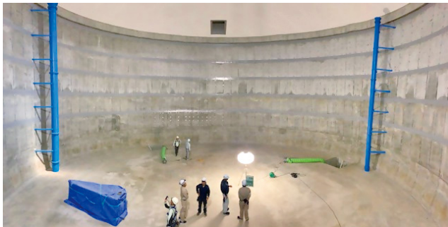
工事中の配水池内部の様子
