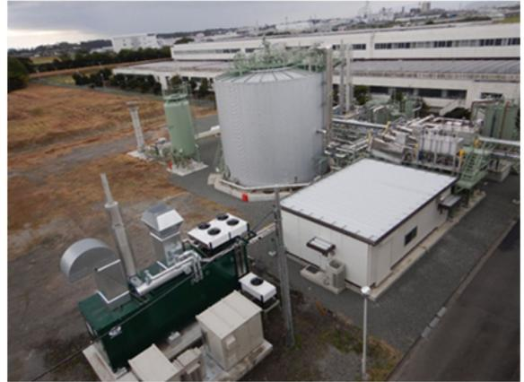
図 東部浄化センターの消化ガス発電施設
