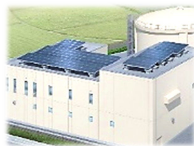
図4-26 富士中央配水池
