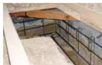
既存の基礎の外側または内側に鉄筋コンクリート基礎を打ち増します。
