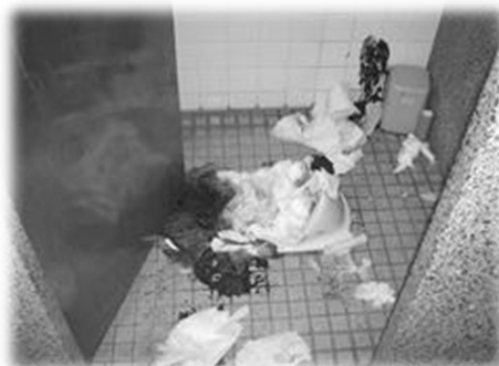
断水により汚れたトイレ
