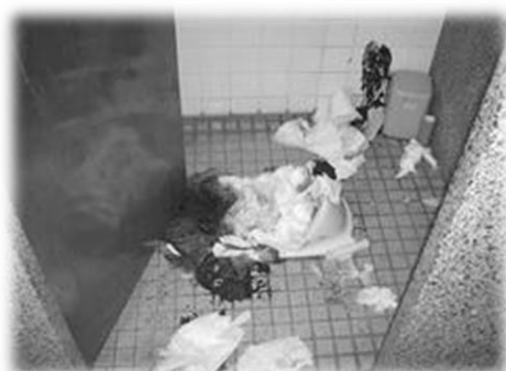
断水により汚れたトイレ
