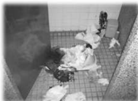
断水により汚れたトイレ
