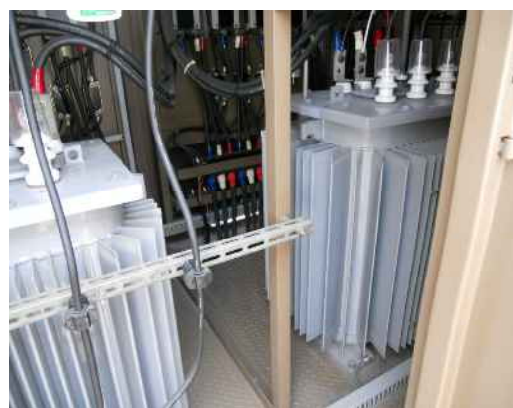
キュービクルと呼ばれる高圧受変電設備 に設置されている変圧器 2 台を更新しました
