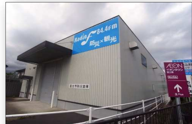
五貫島防災倉庫（平成20年）
